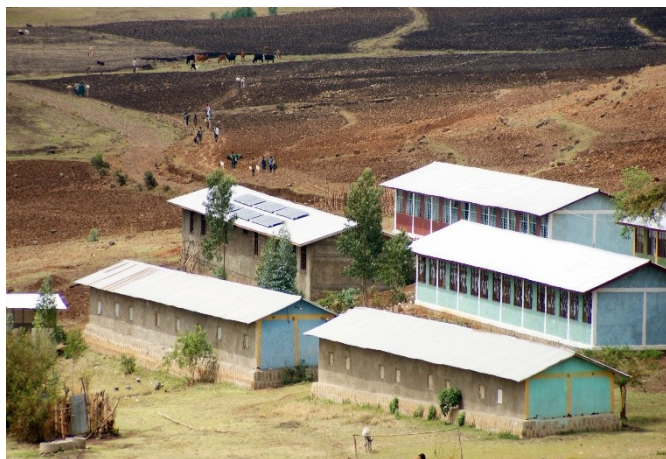
Schulgebäude der Sekundarschule (mit Solar auf dem Dach)
